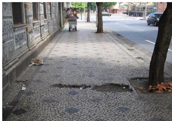
**Figura 5.5:** Falta de Manutenção nas Calçadas
