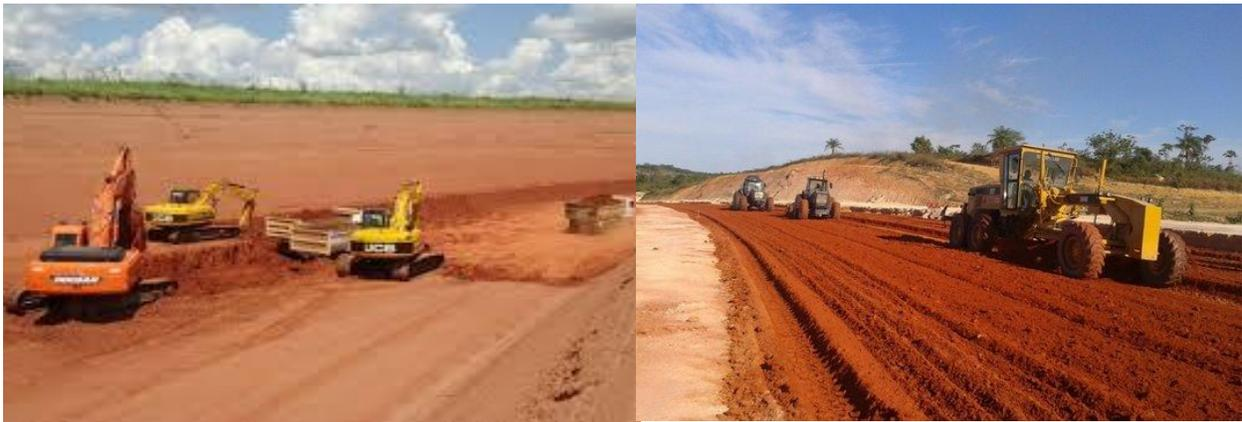
**Figura 4-3 – Serviços de Escavação e Carga e Compactação de Aterro**
