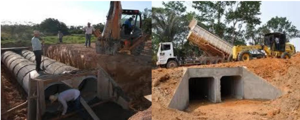
**Figura 4-6 – Serviço de Construção de Bueiro Tubular e Celular**
